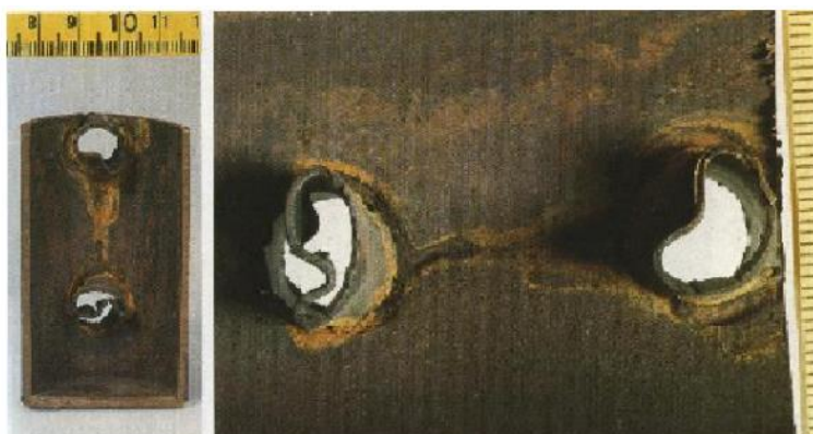
Slika 2.6 Primjer puknuća cijevi zbog djelovanja kontaktne korozije [5]
