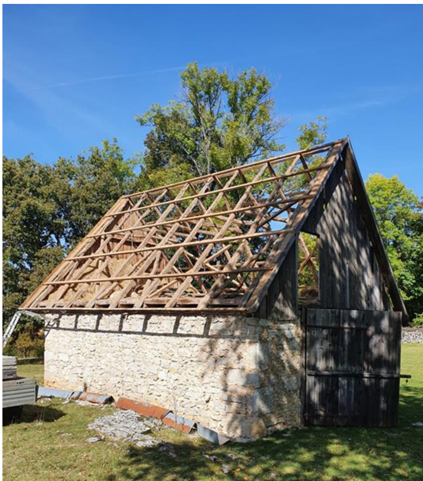
Slika 21 Konstrukcija krova s kojeg je uzeta greda za uzorke
