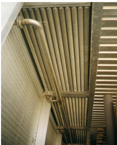
Slika 17. Prikaz izmjenjivača topline unutar sušare [2]
