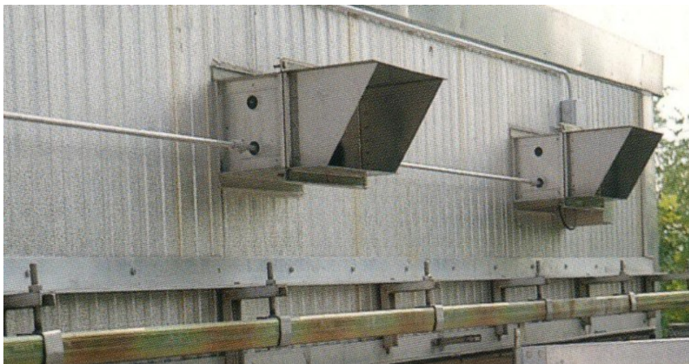
Slika 23. Prikaz pravokutnih bočnih otvora s pokretnom klapnom za odzračivanje [2]
