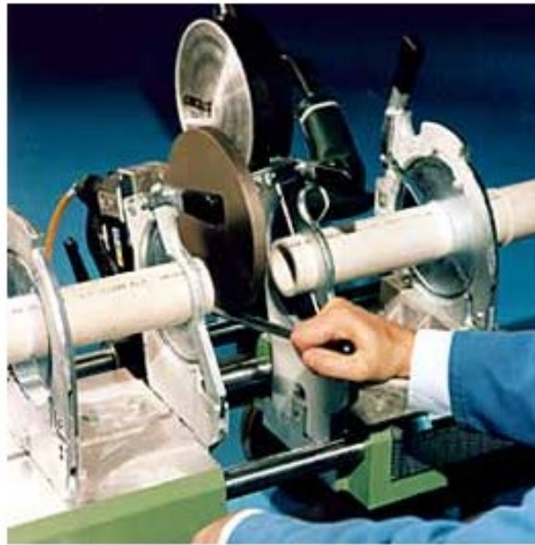
Slika 15. Postavljanje grijaće ploče [13]
