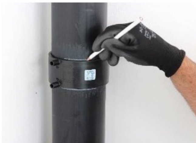
Slika 27. Označavanje mjesta na koje dolazi spojnica [20]
