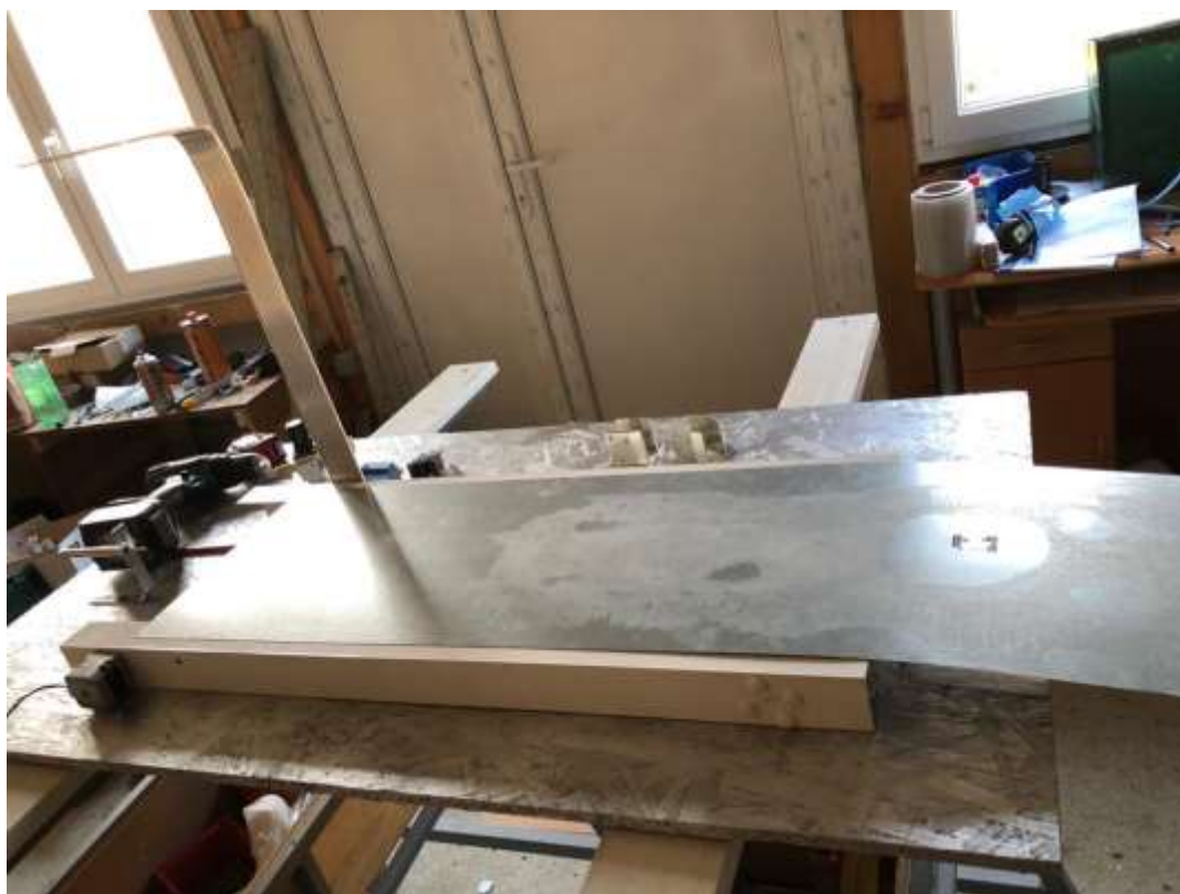
Slika 19. Postavljanje lima na stupove
