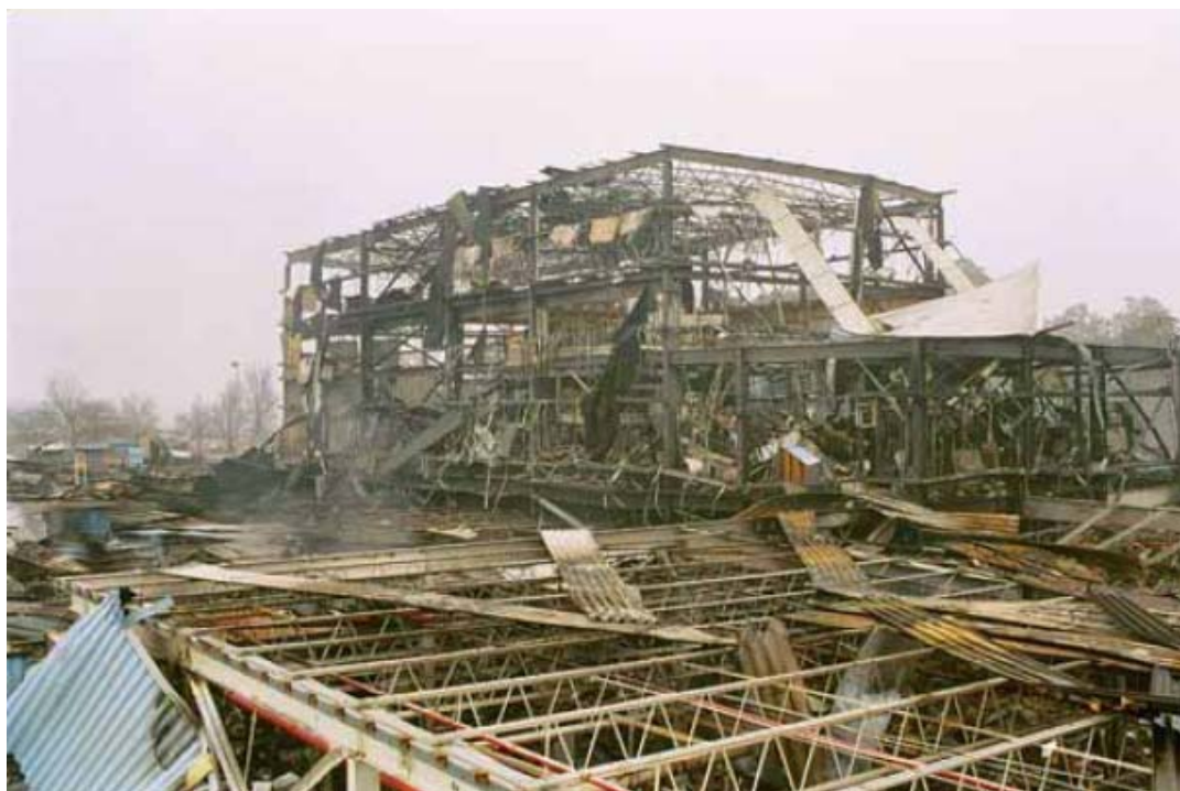
Slika 2.15 Posljedica eksplozije prašine polietilena u “West Pharmaceutical Services, Inc” Kinston, North Carolina [15]
