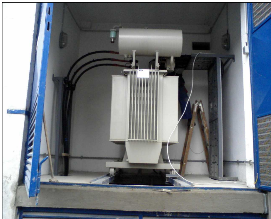
Slika 5-2-1: Distributivni transformator u trafo boksu (arhiva Instituta za elektroprivredu i energetiku d.d, Zagreb)
