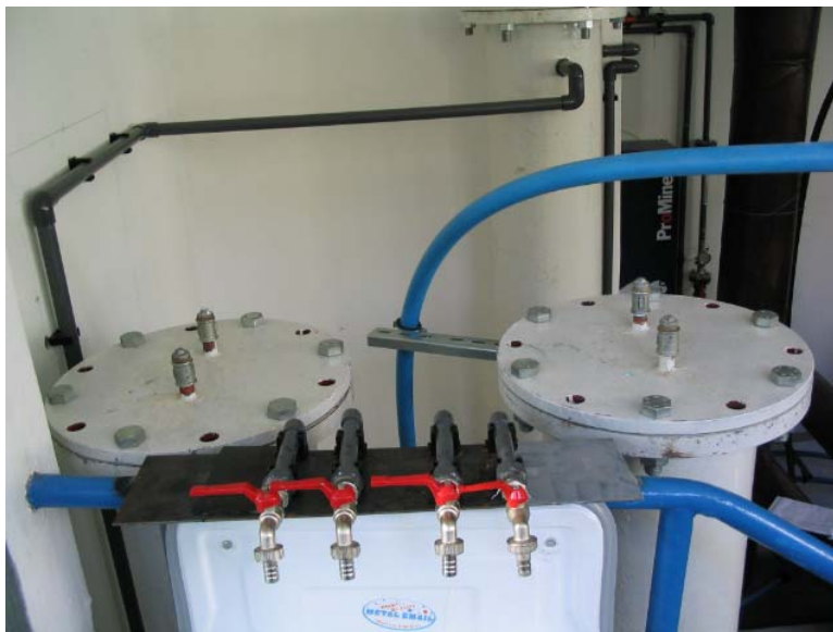
Slika 26. Fotografija mjesta za uzorkovanje pilot uređaja
