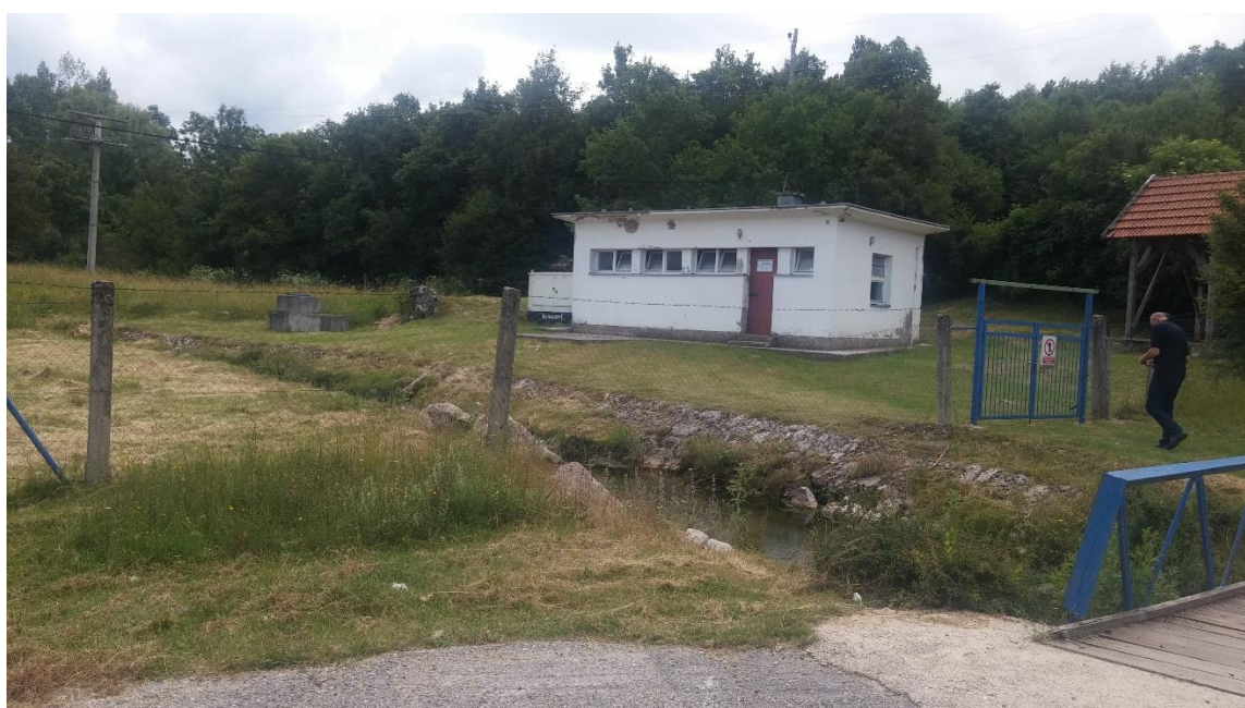
Slika 47. Crpna stanica Kraljevac
