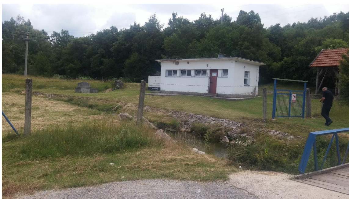
Slika 47. Crpna stanica Kraljevac
