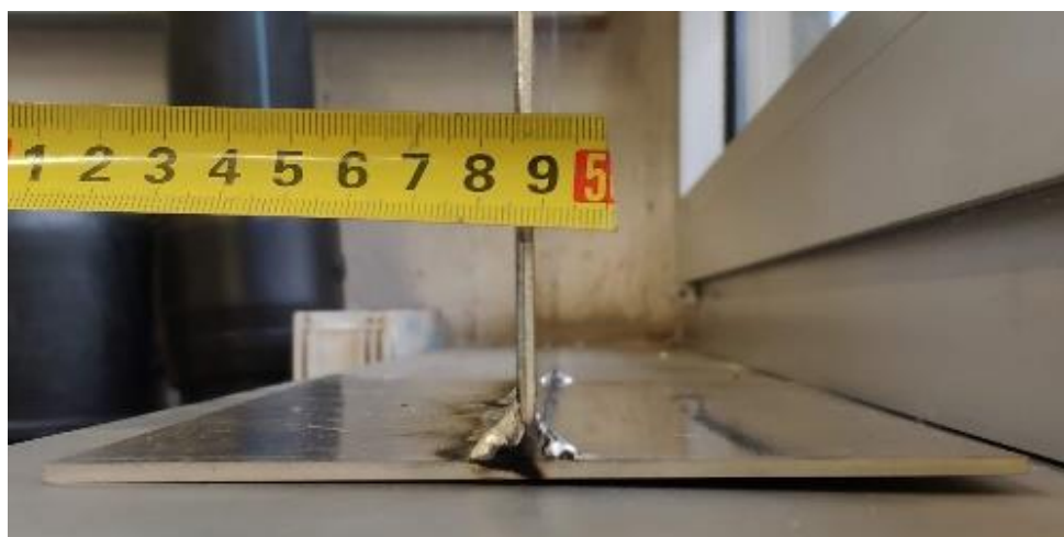
Slika 47. Prikaz deformacije zavara
