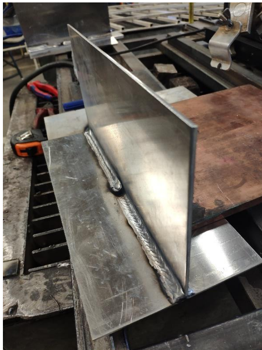
Slika 45. Prikaz zavara nakon zavarivanja duplim pulsom i klasičnim pulsom
