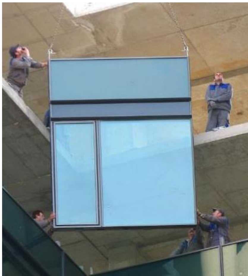
Slika 30. Element fasade pri ugradnji
