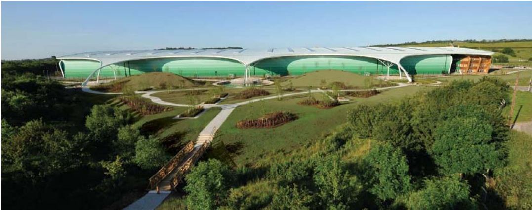
Slika 13. Izgled skladišta nakon izgradnje
