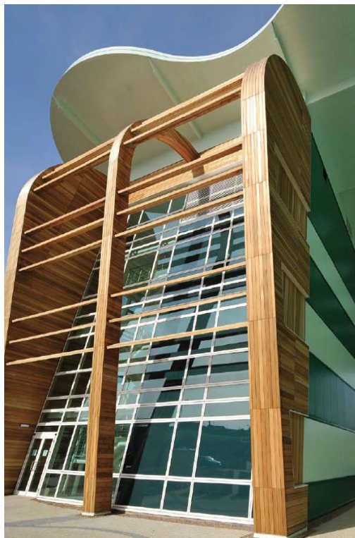
Slika 14. Izgled bočne uredske strane skladišta nakon izgradnje
