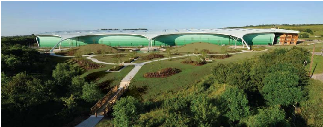
Slika 13. Izgled skladišta nakon izgradnje
