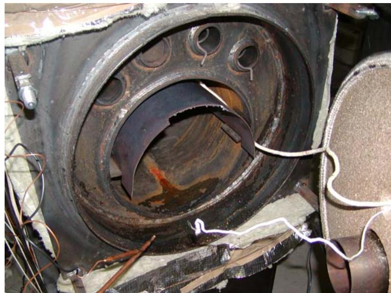
*Slika 5.3 Pogled na ložište s usmjerivačem plamena i dimovodne cijevi s umetnutim turbulatorima u obliku zavojnice*
