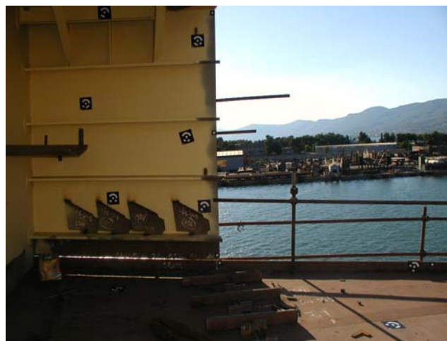
Slika 70: Postavljanje mjernih točaka na navozu
