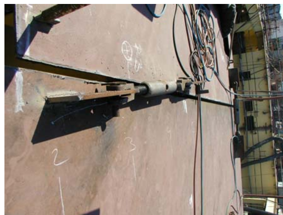
Slika 25: Mehanički pritezač za pozicioniranje sekcije
