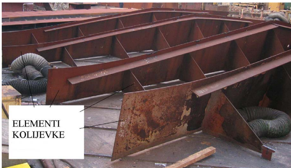
Slika 13: Elementi kolijevke
