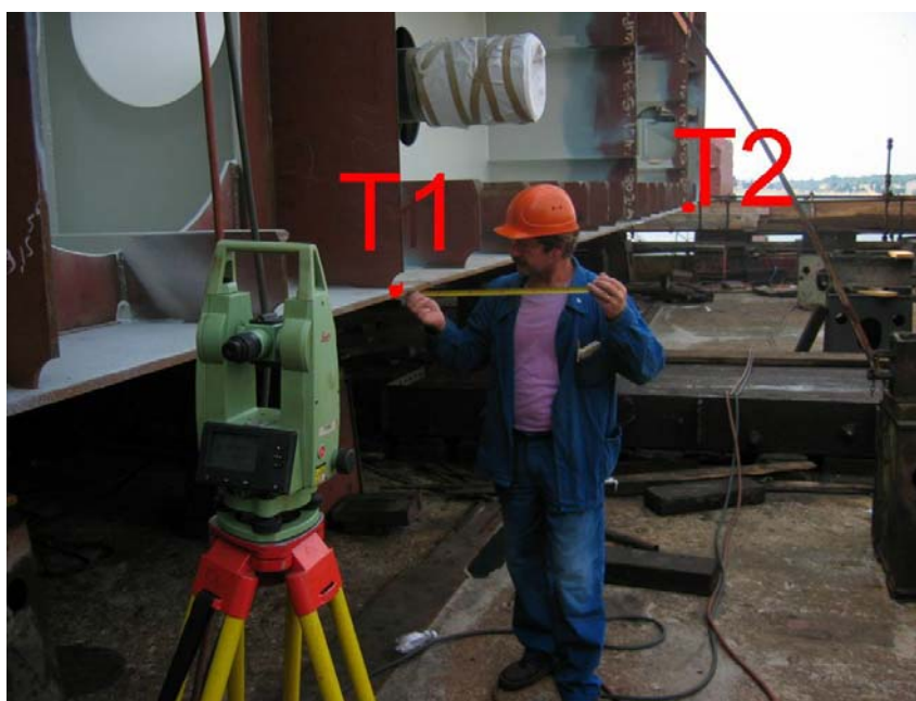
Slika 28: Kontrola okomitosti poprečnog presjeka broda
