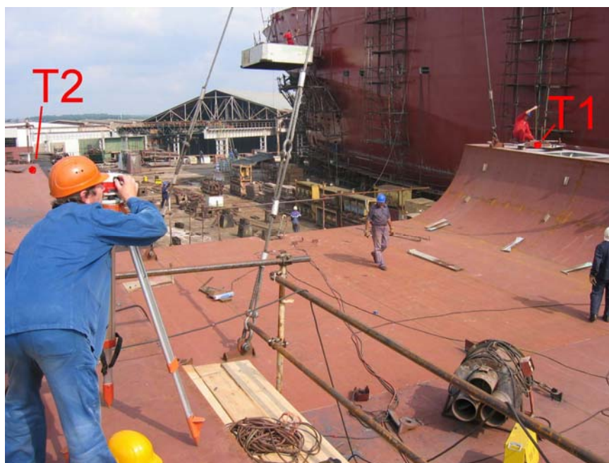
Slika 27: Kontrola poprečnog nagiba sekcije
