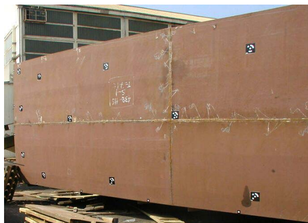
Slika 99: Mjerne točke na vanjskoj oplati na boku broda
