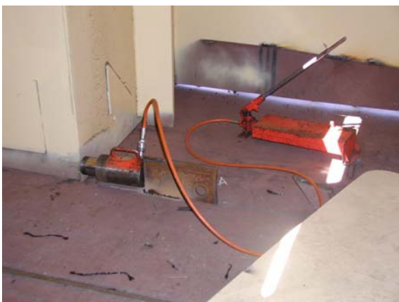
Slika 24: Hidraulička pumpa za pozicioniranje sekcije
