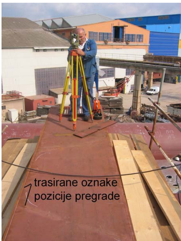
Slika 30: Postavljanje teodolita
