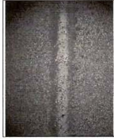
Lc3, vidljiva poprečna puknuća
