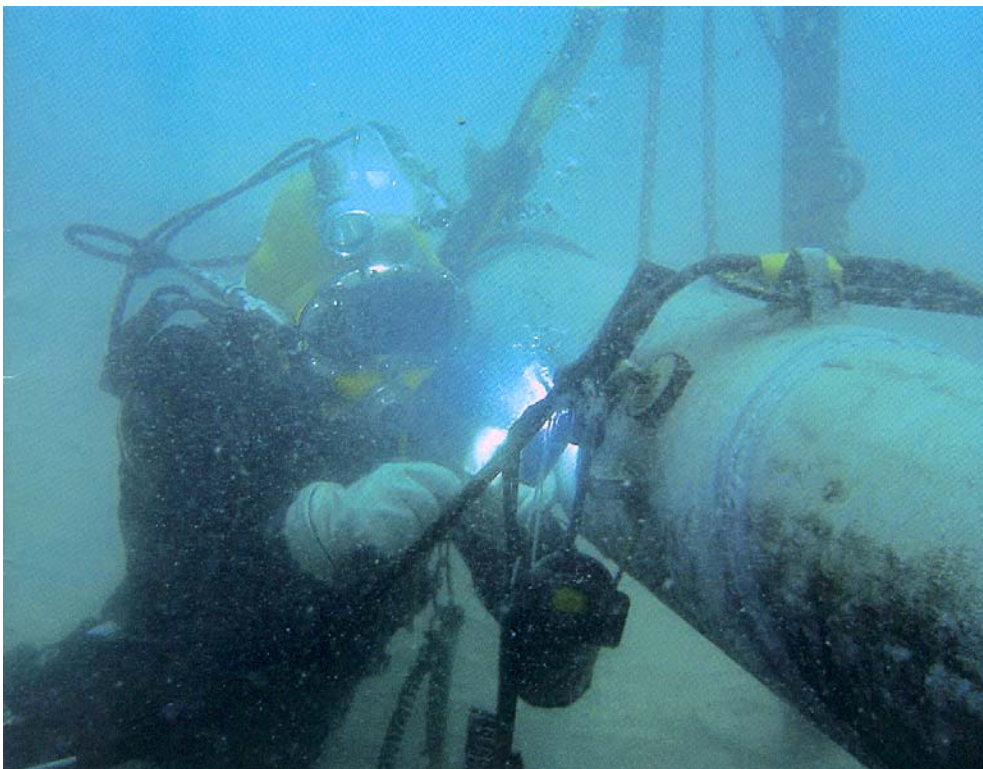
Slika 2.9 Podvodno mokro REL zavarivanje ojačanja na cjevovodu promjera 355mm [20]
