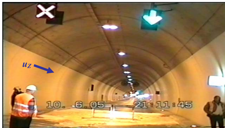
Foto 3: Pogled na tunel prije startanja požarnog testa – pripreme, u_z = 4,0 m/s
