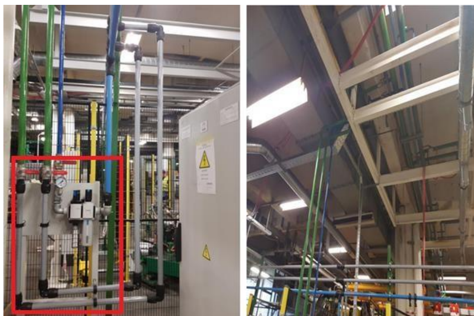
Slika 18 Dovod fluida iz mreže[4]
