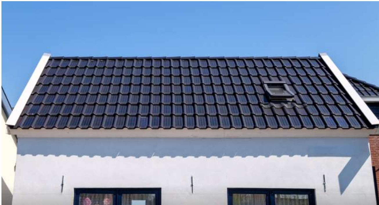
Slika 12. Krov sa solarnim crjepovima [8]
