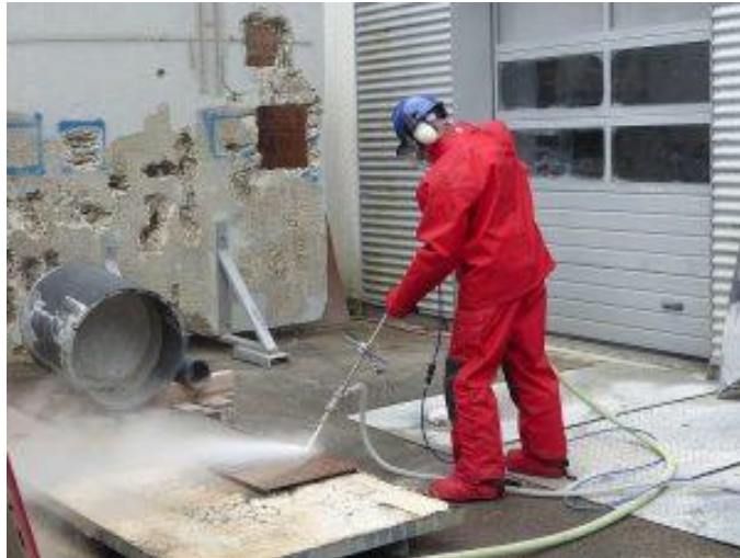
Slika 6.4. Čišćenje površine mlazom vode [27]
