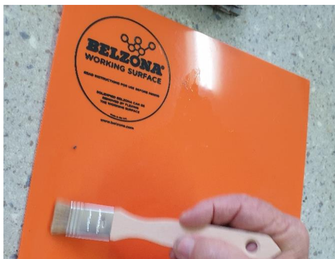
Slika 7.11. Odmašćivanje radne površine na kojoj se miješaju komponente
