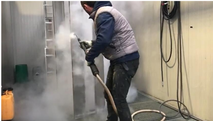
Slika 6.1. Obrada površine parom prije nanošenja premaza [26]
