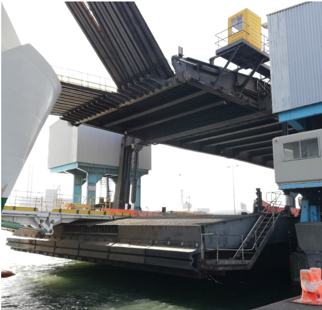
Slika 3. Linkspan s mogućnošću prihvata vozila na više paluba
