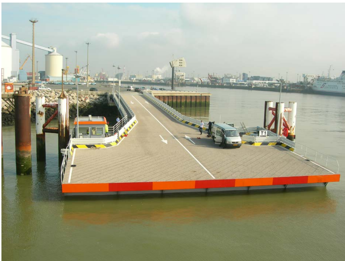
Slika 1. Linkspan u luci grada Calais
