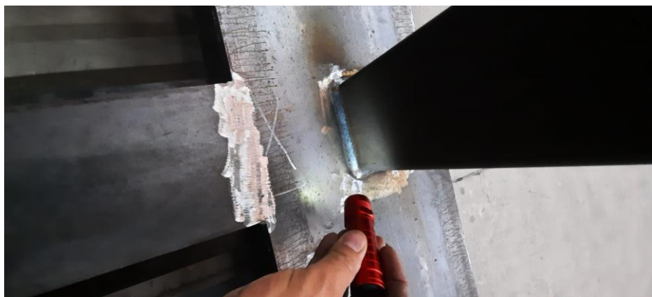
Slika 10. Vizualna kontrola zavara
