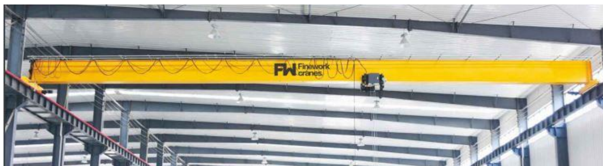
Slika 6. Mosni granik proizvođača FineWork Cranes [8]
