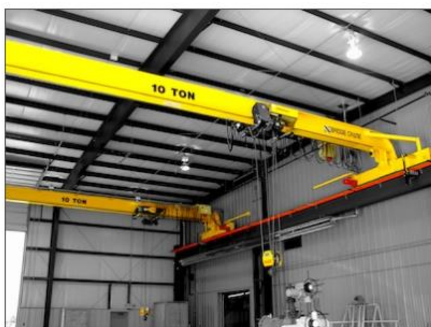
Slika 6. Bridge Crane mosni granici s ovješnim vitlom [3]
