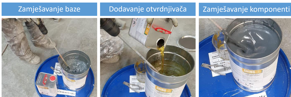
Slika 33. Priprema boje za zračno prskanje
