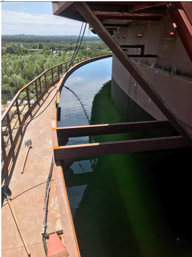
Slika 17. Primarno ukrućenje plašta
