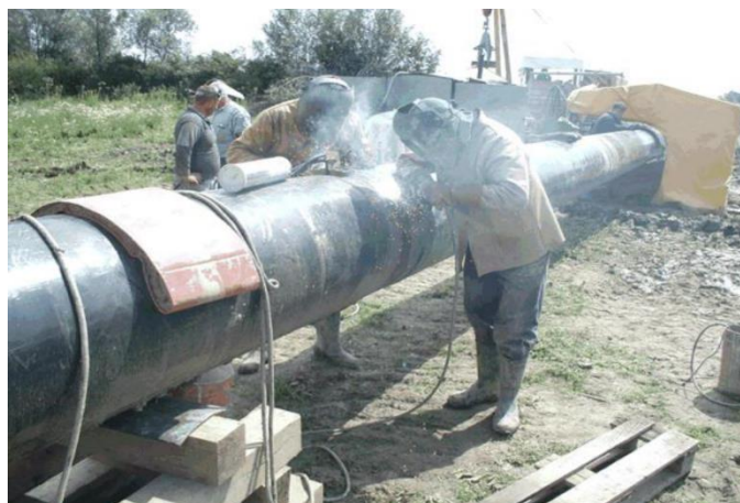
Slika 30. REL zavarivanje cjevovoda celuloznom elektrodom (silazna tehnika) [15]
