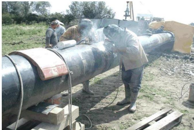
Slika 30. REL zavarivanje cjevovoda celuloznom elektrodom (silazna tehnika) [15]
