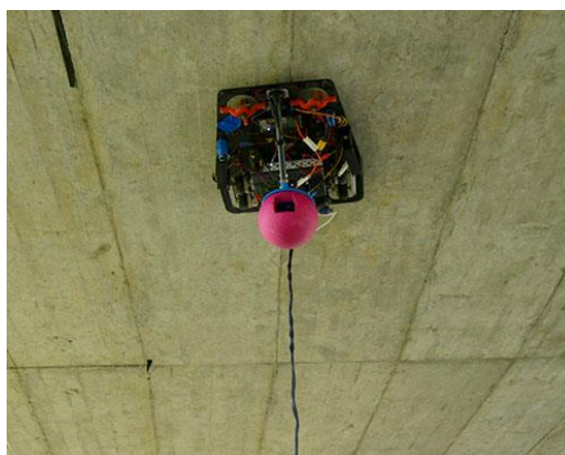
Slika 15. Inspekcija pomoću robota [17]
