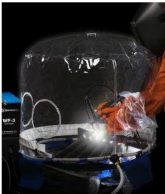
Slika 21. Izvođenje postupka zavarivanja u komori za zavarivanje [12]
