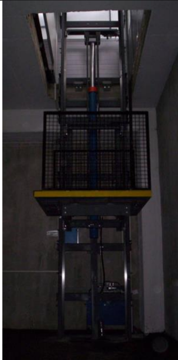
Slika 2. Teretna platforma s hidrauličnim pogonom [3]
