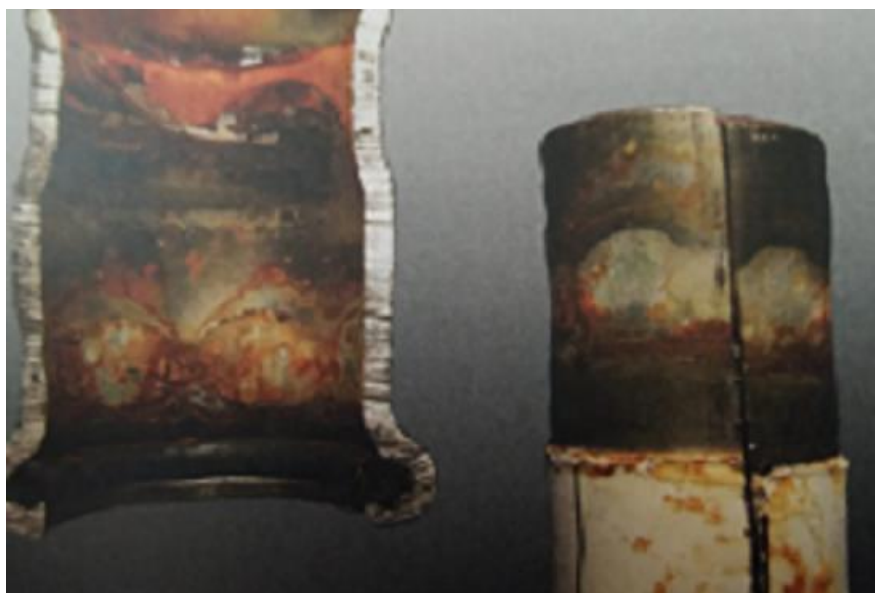
Slika 49. Korozija u procijepu nastala zbog djelovanja bakterija [1]
