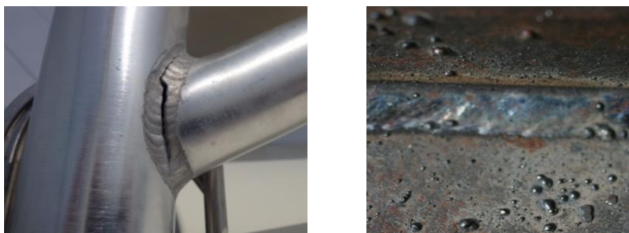
Slika 11. Nehomogenosti na površini zavarenih spojeva, pukotina – (lijevo), naštrecane kapljice metala nastale zbog neprimjerenih parametara zavarivanja – (desno) [17, 18]
