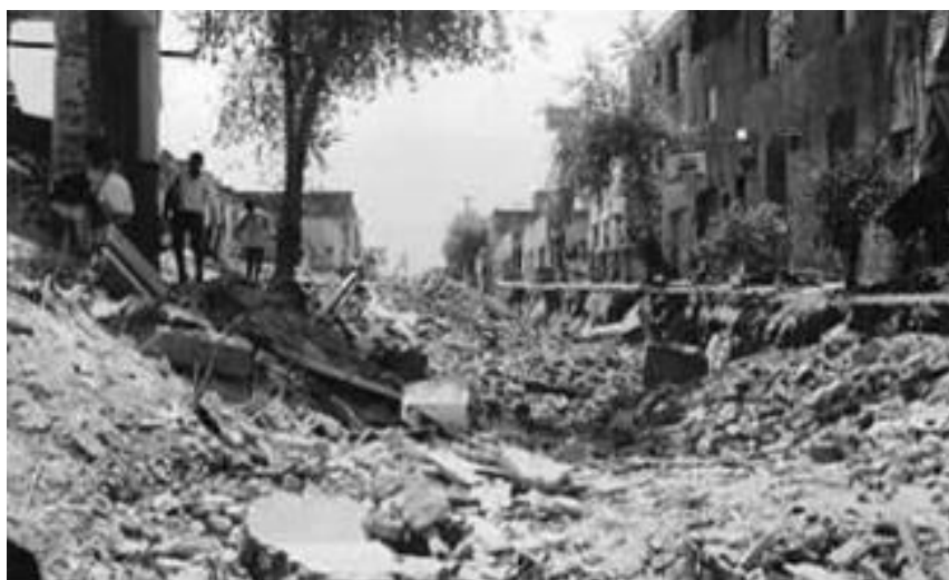
Slika 14. Eksplzija kanalizacionog sustava u Guadalajari 1992. g. [15]
