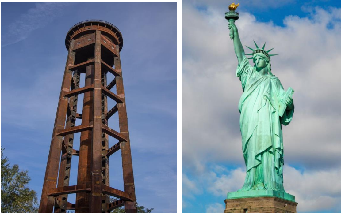
Slika 17. Opća korozija čelične konstrukcije vodotornja-(lijevo) i jednolika zahvaćenost zelene patine na Kipu slobode-(desno) [23, 24]
