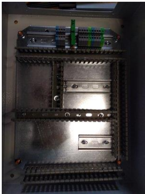
Slika 28. Montiranje nosača
