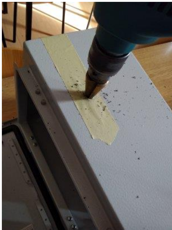
Slika 30. Bušenje razvodnog ormara
