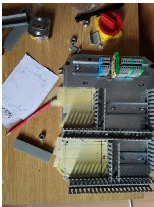
Slika 29. Montiranje uzdužnih kabelskih kanala
