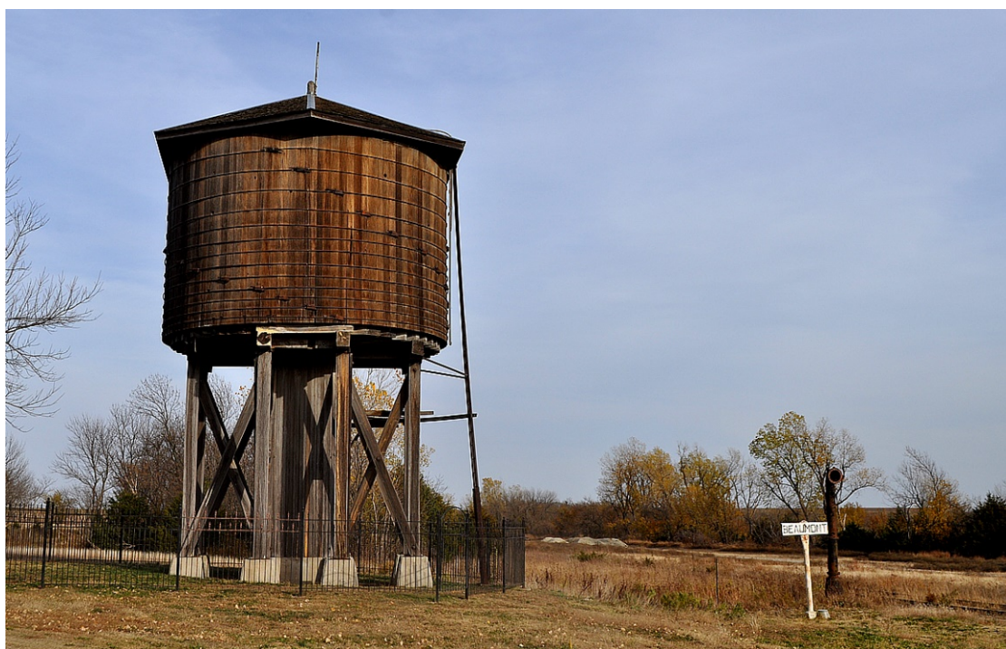
Slika 1. Vodotoranj izgrađen 1875. g. u Kansas-u, SAD
