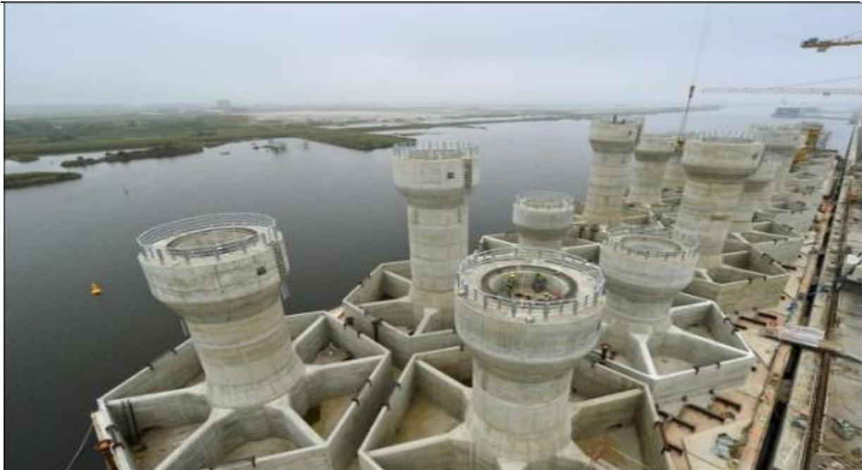
**Slika 10. Primjer temelja s gravitacijskom betonskom bazom [9]**
