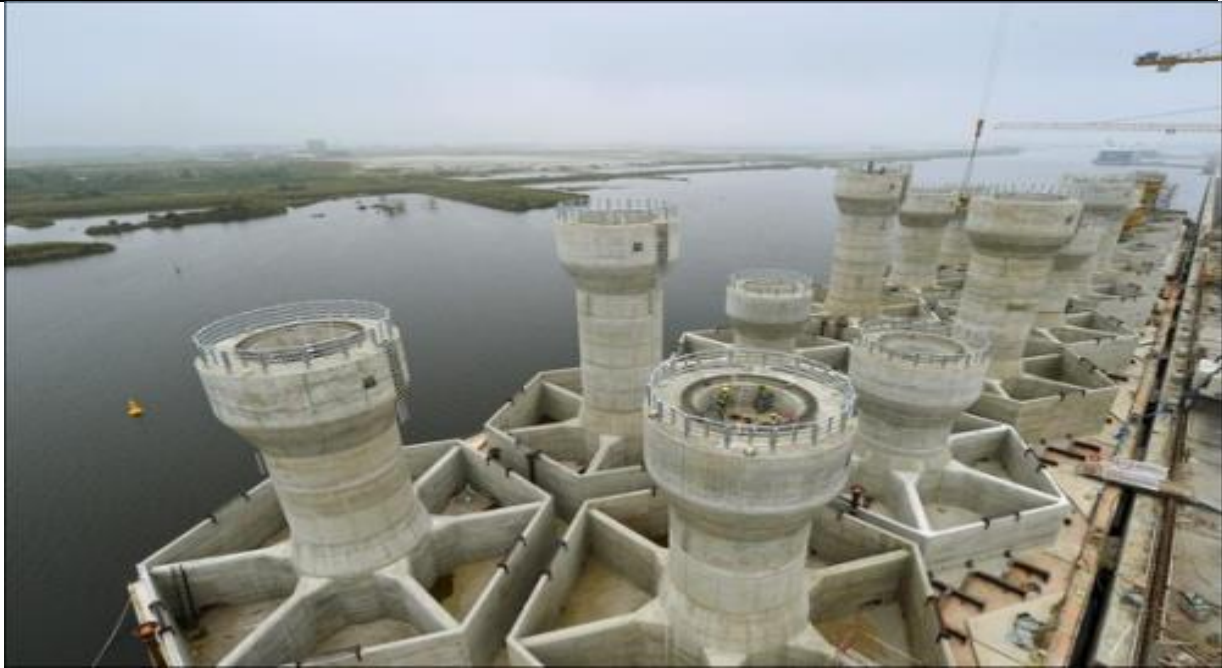
Slika 10. Primjer temelja s gravitacijskom betonskom bazom [9]
