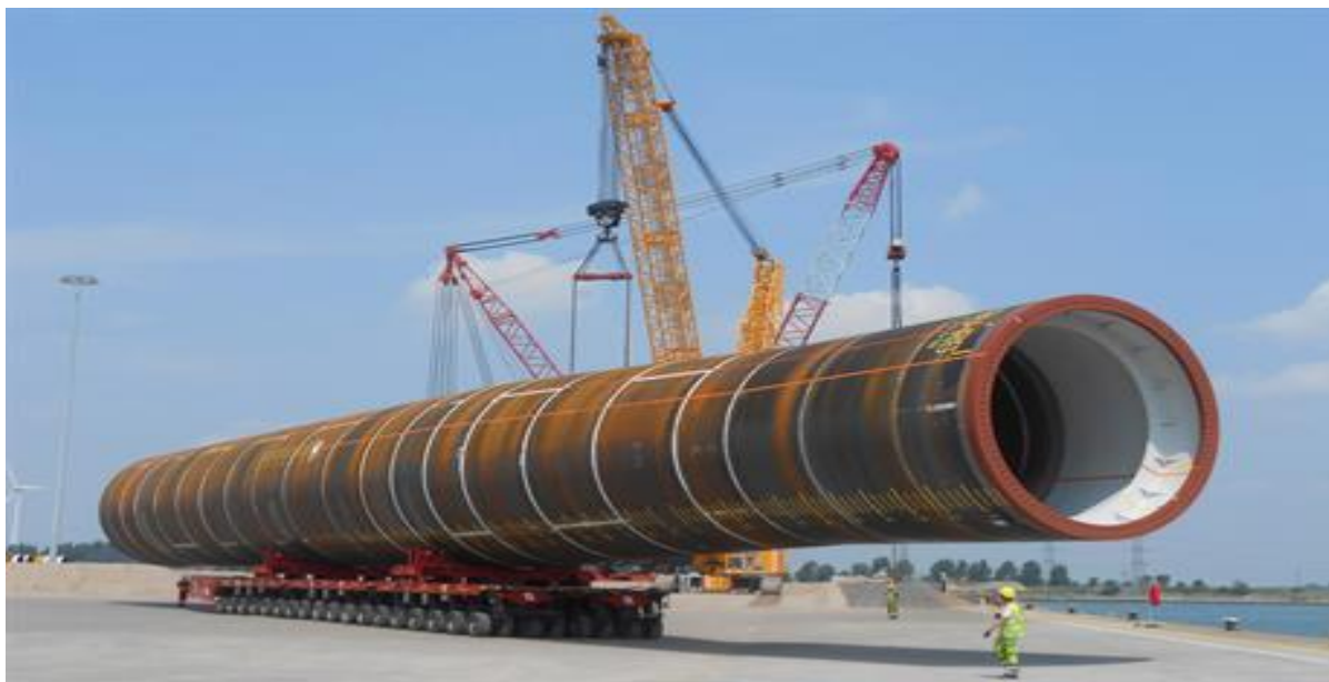
Slika 9. Primjer jednostupnih temelja [8]
