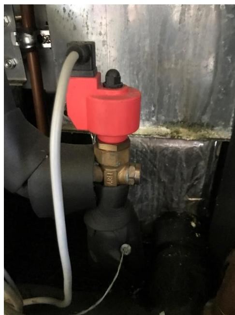
Slika 16: Elektronički ekspanzijski ventil
