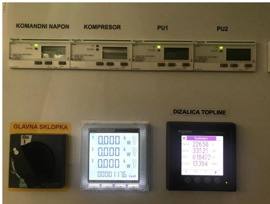
Slika 19: Multimetri za mjerenje električnih snaga komponenti
