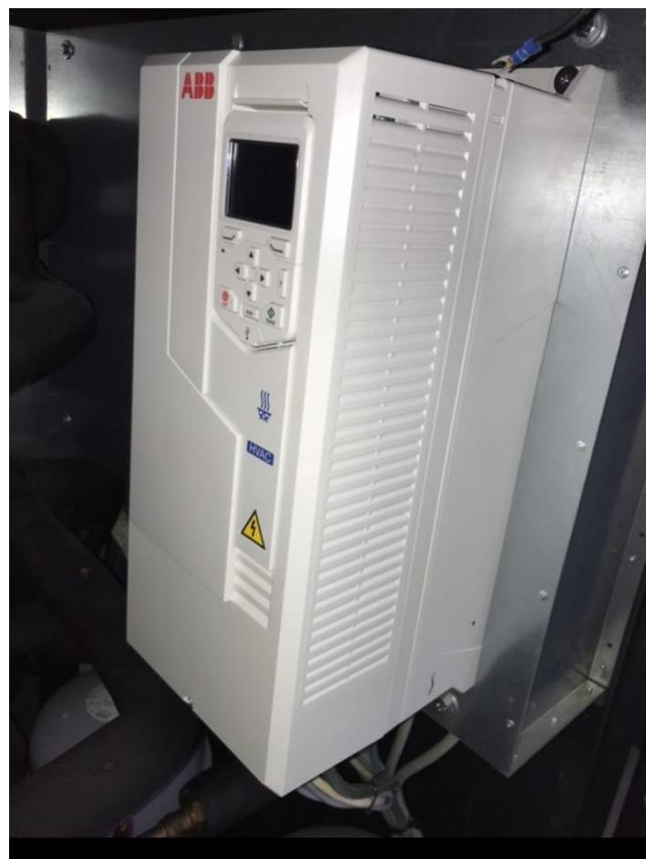
Slika 21: Frekvencijski pretvarač ABB ACH580-01
