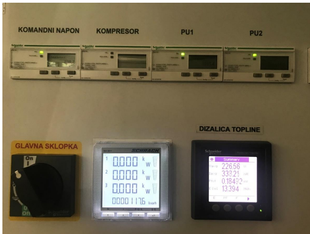
Slika 19: Multimetri za mjerenje električnih snaga komponenti
