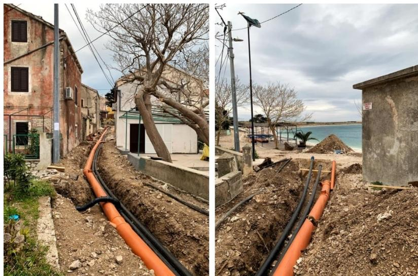
Slika 16. Proces izgradnje vodovodne i kanalizacijske mreže [44]
