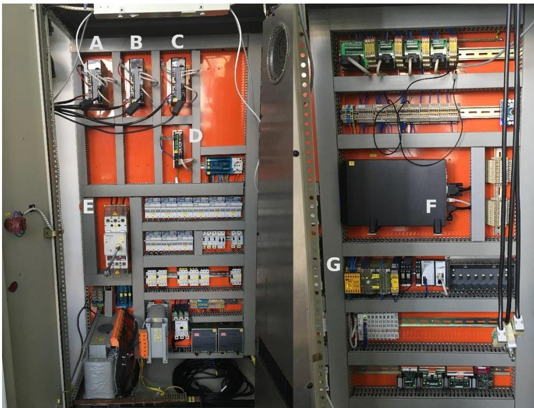
Slika 13. Dijelovi upravljačkog ormara ispitnog CNC postava
