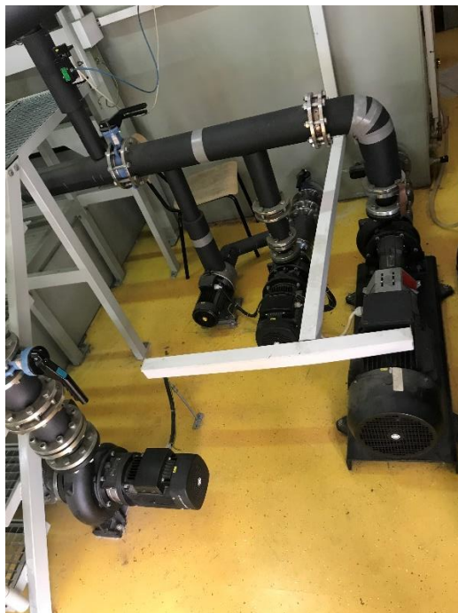
Slika 20. Tri Pumpe za potrebe dobave vode
