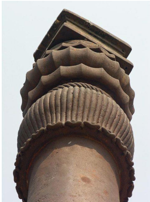
Slika 11. Vrh željeznog stupa [19]
