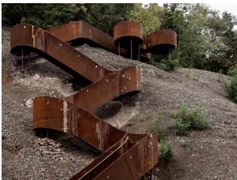
Slika 23. Chemin des Carrières, Rosheim ,Francuska [34]
