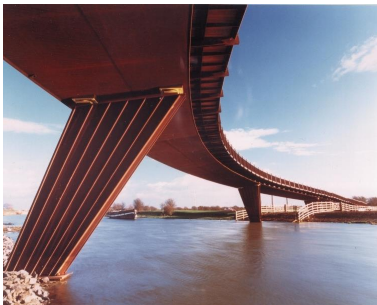
Slika 19. Millennium most izrađen od Cor-Ten čelika, Engleska [31]
