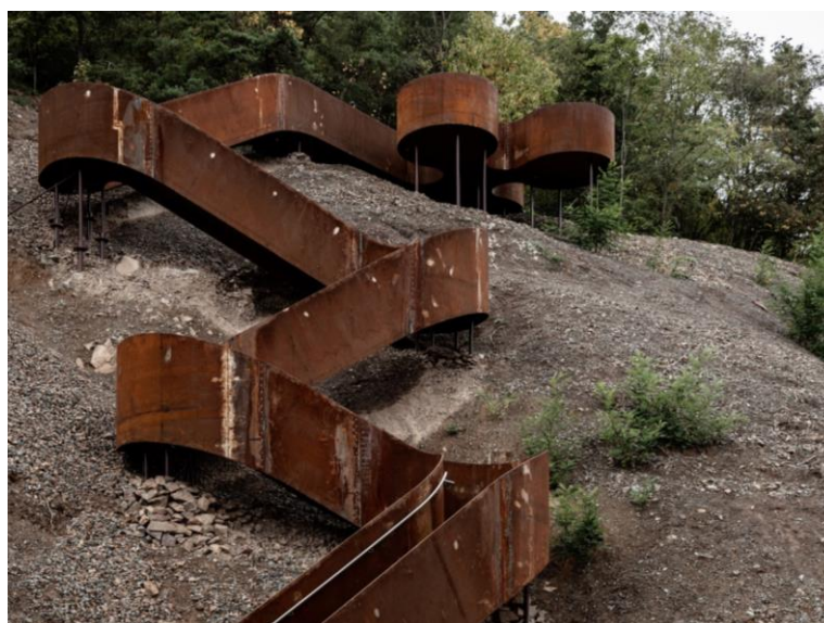
Slika 23. Chemin des Carrières, Rosheim ,Francuska [34]
