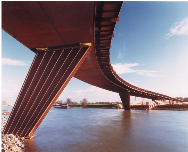
Slika 19. Millennium most izrađen od Cor-Ten čelika, Engleska [31]
