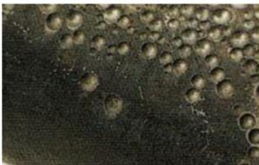
Slika 5. Pojavni oblik rupičaste korozije na titanovoj leguri [11]
