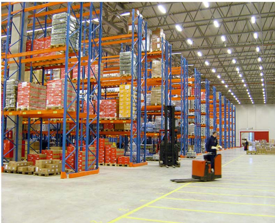
Slika 2. Unutrašnjost logističkog centra
